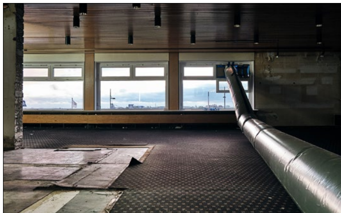
Sanierungsarbeiten im Scharoun-Gebäude mit Blick über die Weser auf Blexen. (Foto: Niels Hollmeier/DSM)
