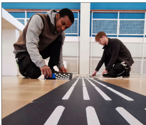
Ismaila Jallow und Rico Reuter vom Team der DSM-Werkstatt bei der Einrichtung des neuen taktilen Bodenleitsystems in der Koggehalle. (Foto: Annica Müllenberg/DSM)
