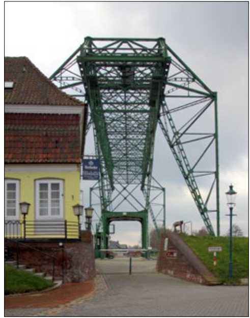
Osten: Zufahrt zur Schwebefähre (2018). Sie wird von Fußgängern und Zweiradfahrern genutzt.
