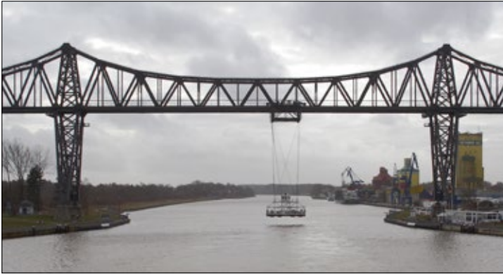
Die Schwebefähre Rendsburg auf ihrem Weg über den Kanal (2006). Die Schiffsbegrüßungsanlage ist unterhalb der Brücke am rechten Bildrand zu erkennen.
