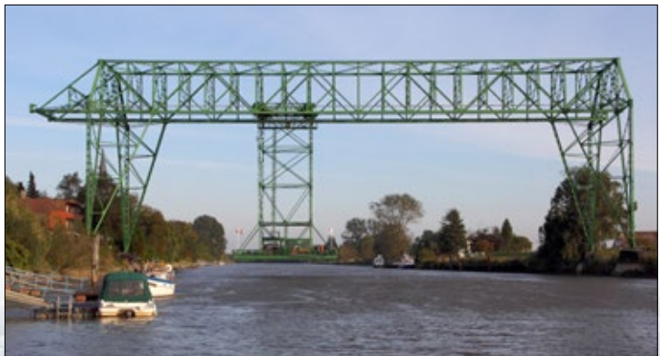
Die Schwebefähre Osten – Hemmoor in der Seitenansicht (2013).
