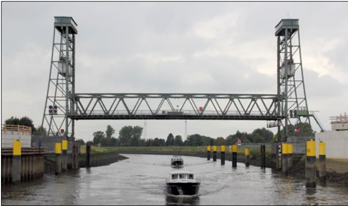
Die Hubbrücke Huntebrücke in der ersten Hubstufe (2014). Gut zu erkennen sind die Gegengewichte in den Hubtürmen. Die Betonfundamente für die neue Klappbrücke sind bereits gegossen. (Foto: Helmut Seger)
