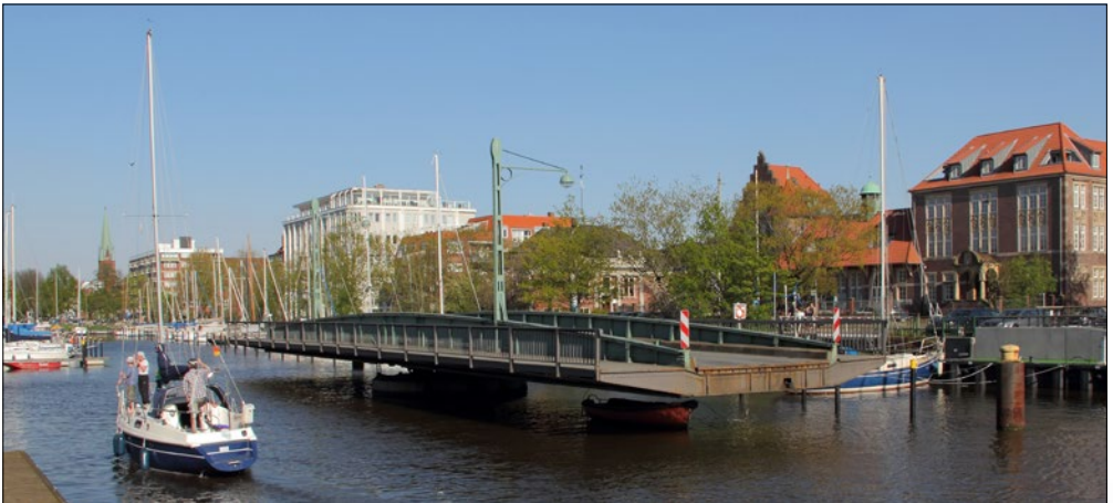
Die geöffnete Drehbrücke gibt heute den Weg zu den Liegeplätzen des Weser Yacht Clubs im Geestemünder Hauptkanal frei. Bei 4,80 Meter Breite und zwei Fußwegen bleibt nur Platz für einspurigen Fahrzeugverkehr (2016). Ab 1877 mussten für einige Jahrzehnte auch die für den Holzhafen bestimmten Flöße die Brücke passieren, ehe die Zufahrt zum Holzhafen in den 1930er-Jahren zugeschüttet wurde. (Foto: Helmut Seger)
