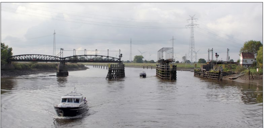
Die eingleisige Eisenbahnbrücke über die Hunte bei Elsfléth mit der geöffneten Drehbrücke auf dem nördlichen Brückenpfeiler, rechts im Bild (2014). (Foto: Helmut Seger)
