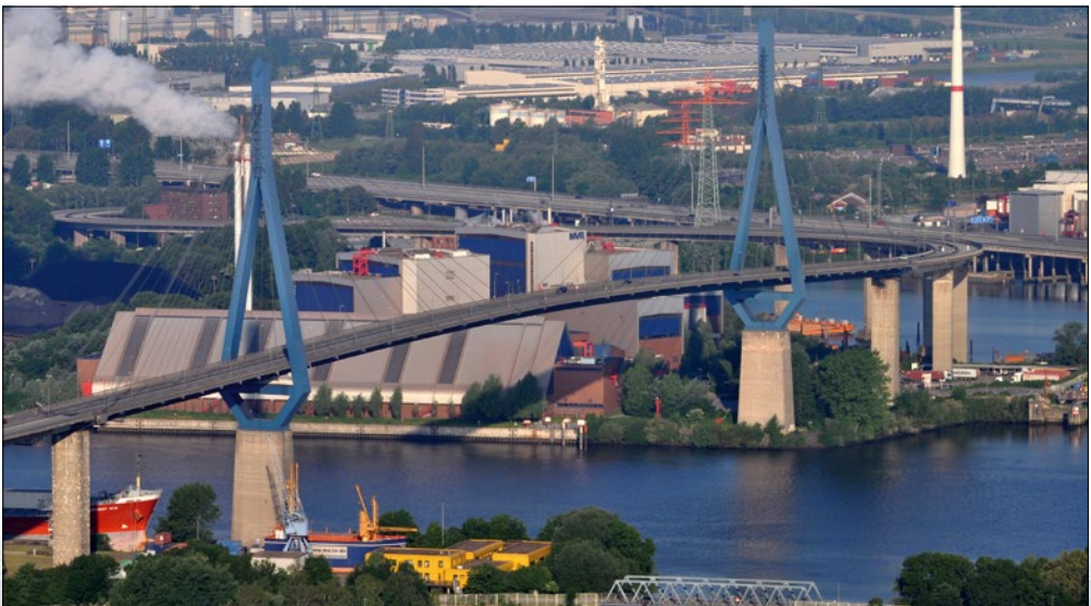
Luftaufnahme der Köhlbrandbrücke in Hamburg (2013). (Foto: @ Ajepbah, Wikimedia Commons, CC-BY-SA 3.0 DE)
