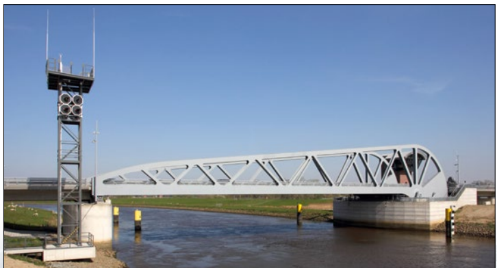
Die 2015 eröffnete Klappbrücke über die Hunte zwischen Berne und Elsfleth (2019). (Foto: Helmut Seger)
