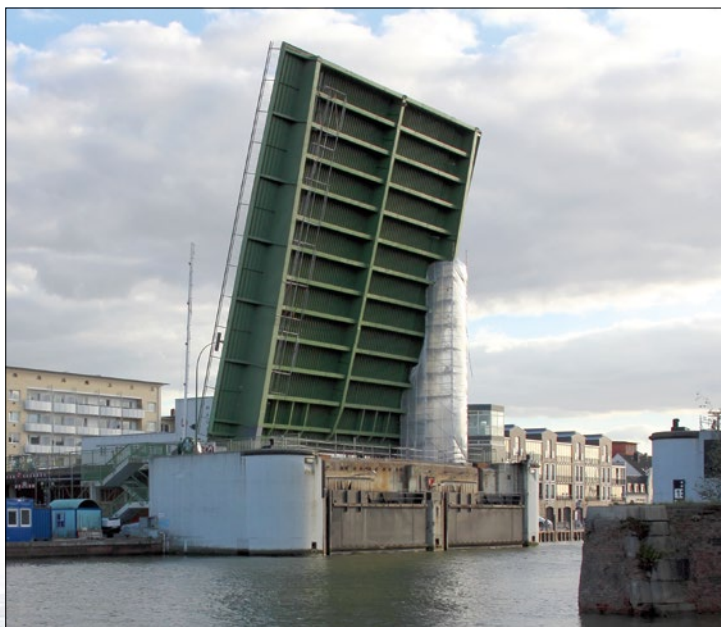
Reparaturarbeiten ermöglichen einen Blick auf die hochgeklappte Kennedy-Brücke (2018). (Foto: Helmut Seger)
