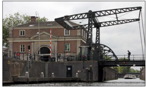
Die einflügelige Brücke über die Entrepotsoksluis wurde um 1902 errichtet. Die Straße Hoogte Kadijk wird über die Brücke geführt (2015). (Foto: Helmut Seger)
