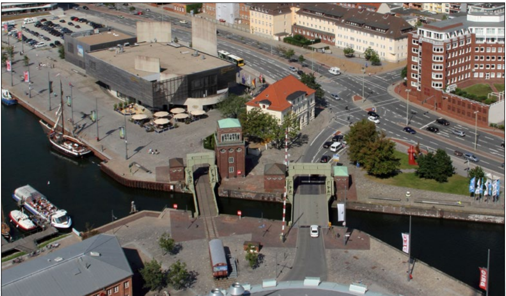
Das Brückenensemble Alter und Neuer Hafen mit den Maschinenhäusern. Im Obergeschoss des Turmes befindet sich der Steuerraum. Die Öffnung der Brücken ist immer sehenswert (2018). (Foto: Helmut Seger)
