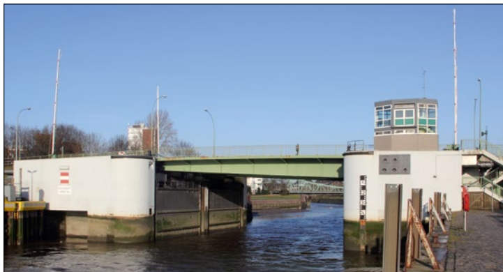
Unter der Klappe der Kennedy-Brücke erkennt man zwei der insgesamt vier Stemmtore des Sperrwerkes, die bei Sturmflut geschlossen werden (2015). (Foto: Helmut Seger)
