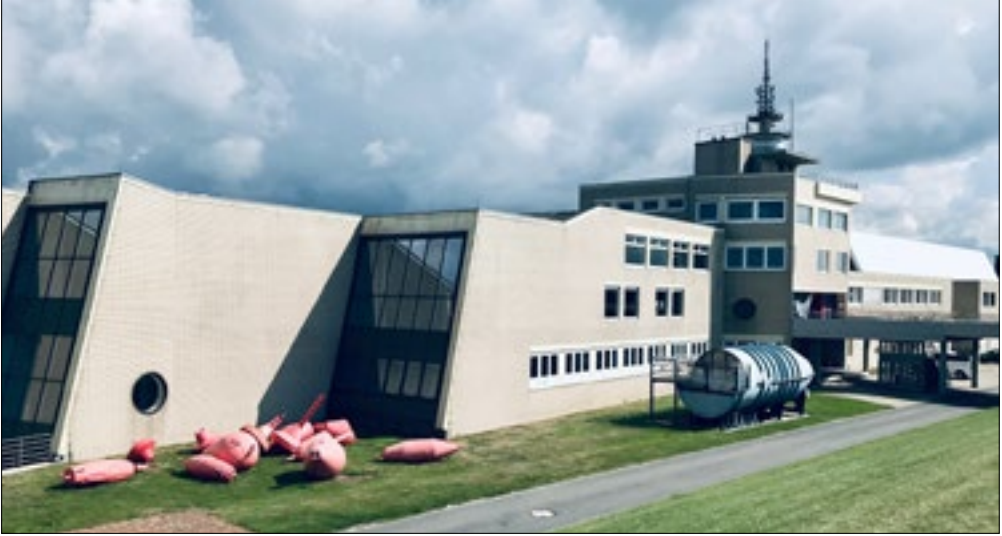
Aktuelle Ansicht des Scharoun-Baus von der Nordwestseite (Deich) aus. Die ineinander verschränkten Architekturelemente beinhalten eckige und runde Fenster sowie schräge Kanten in zunächst ungewöhnlich wirkender Proportion. (Foto: Karolin Leitermann/DSM)
