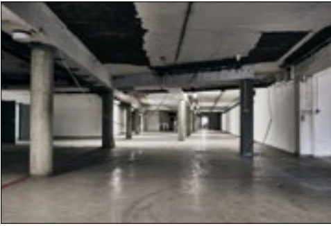
Blick in das ausgeräumte Magazin Richtung Süden. Auch hier findet sich der säulenartige Charakter der Architektur wieder. (Foto: Niels Hollmeier/DSM)
