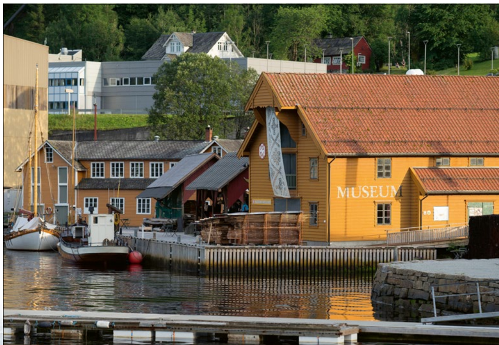
Außenansicht des Hardanger fartøyvernssenter. (Alle Fotos zu diesem Beitrag: Verf.)
