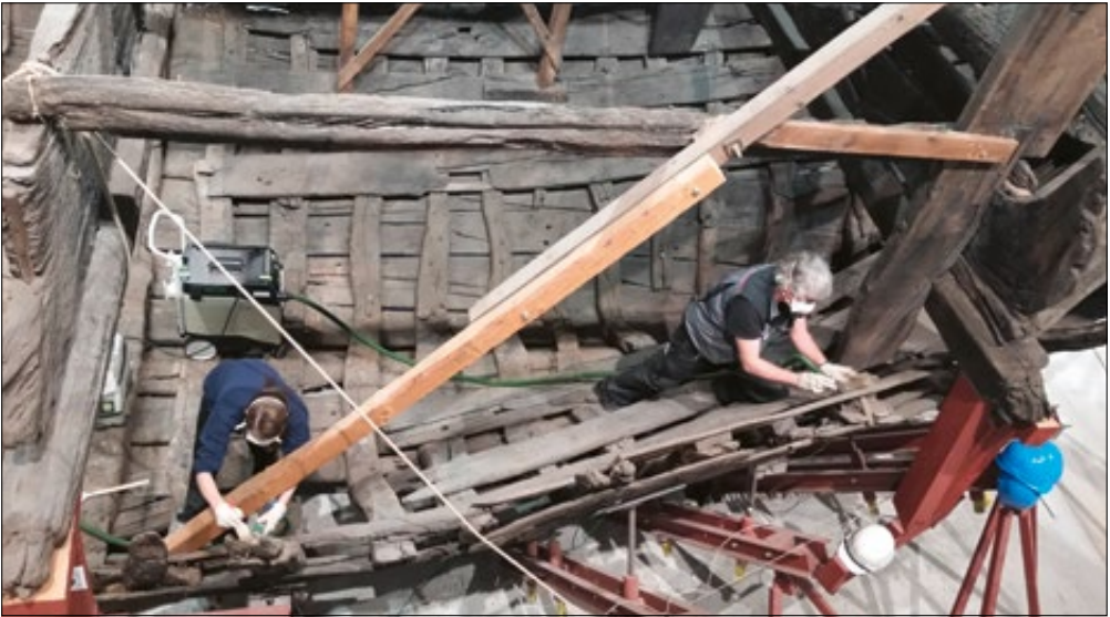
Nach Abschluss der Bauarbeiten in der Kogge-Halle im Januar 2017 musste die Kogge erst einmal von Hand gereinigt werden. (Foto: Tobias Wulf)
