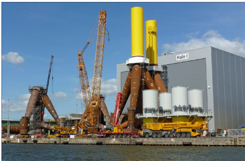
Den Bau der mächtigen Tripods, die als Fundamente für die Hauptpfähle der Windenergieanlagen dienen, konnten die Exkursionsteilnehmer bei der Besichtigung der Produktionsanlagen hautnah erleben. (Foto: Sigrid Kiedel)
