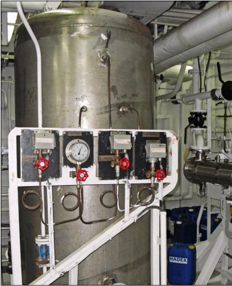
Auf Fracht- und kleinen Passagierschiffen sorgt ein Trinkwassertank mit Luftpolster für die Trinkwasserversorgung. (Foto: Verf.)
