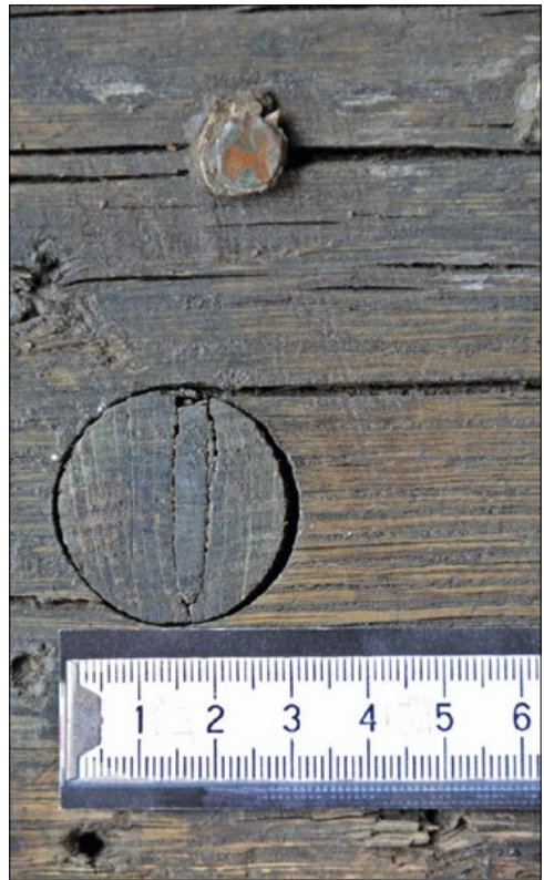
Überreste eines Kupfernagels mit Teerfilzresten (oben) und Holznagel mit erkennbarem Splint.
