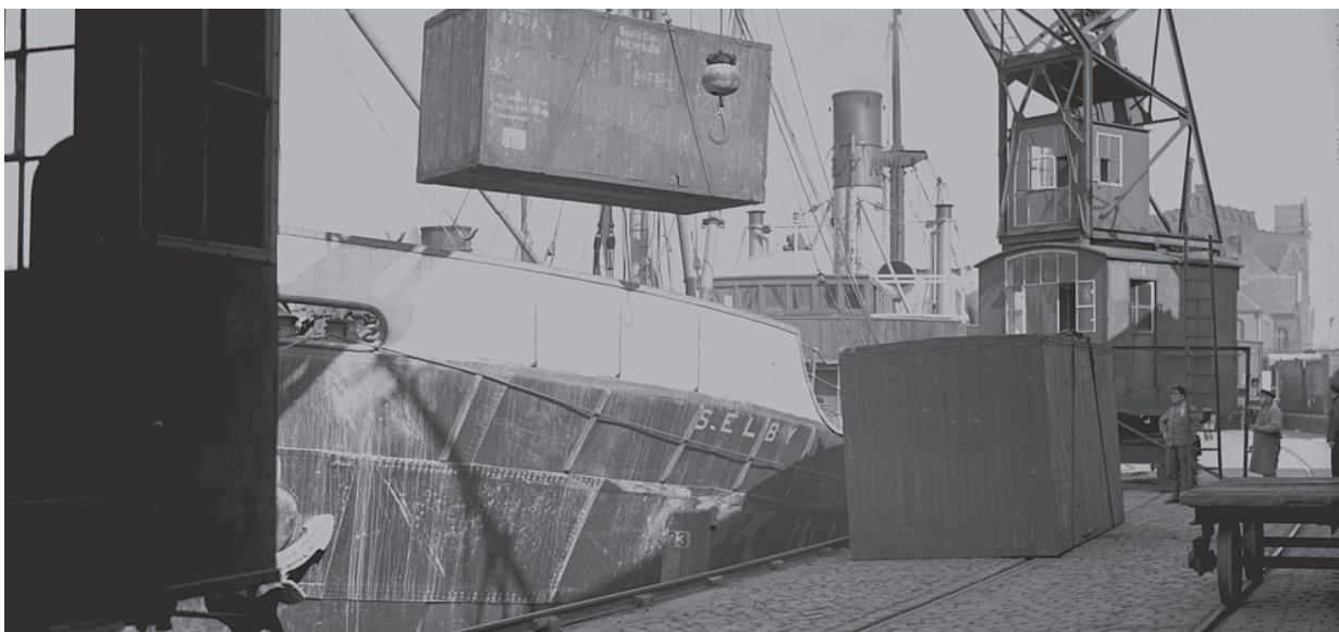
Verladung eines Lifts im Hafen.
