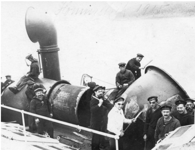
Abb. 4: Instandsetzungsarbeiten am Lüfter der BERLIN. (Foto: Europeana )
