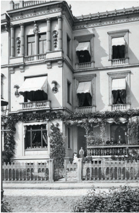
Abb. 61 Das dreigeschossige Haus Contrescarpe Nr. 52 war eines von zwei gleichen Häusern, die der Maurermeister Friedrich Wilhelm Docke 1866 erbaute. Eines der beiden Häuser erwarb der Kaufmann August Ludwig Muhle. Contrescarpe Nr. 51 wurde im Zweiten Weltkrieg völlig zerstört, während Nr. 52 fast im ursprünglichen Zustand erhalten blieb. Im gleichen Jahr 1866 ließ auch der Kaufmann Friedrich Vietor durch den Baumeister Heinrich Gottfried Dietrich an der Contrescarpe Nr. 50 ein Haus erbauen. (StA Bremen, Bildarchiv)
