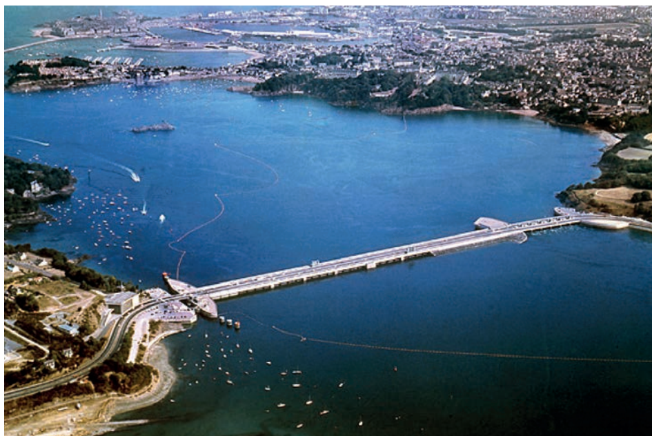
Abb. 18 Gezeitenkraftwerk La Rance in der Bretagne/Frankreich mit einer jährlichen Leistung von etwa 550 Millionen Kilowattstunden. (Foto: Wikipedia)
