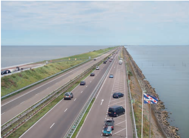
Abb. 11 Damm zwischen der salzreichen Nordsee (links) und dem mit Süßwasser gefüllten IJsselmeer (rechts). (Foto: C. Messier/Wikipedia, CC BY-SA 4.0)
