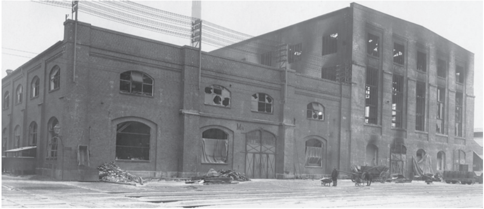
Abb. 4 Das zerstörte Prüfstandsgebäude im Nürnberger Werk der MAN, in dem die Maschine stand. (Foto: HA MAN Diesel & Turbo SE, Augsburg, Sign. 317 II, 12000 PSI)
