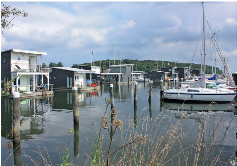
Abb. 15 »Floating Houses« in der Marina »im-jaich«, Lauterbach/Rügen.
