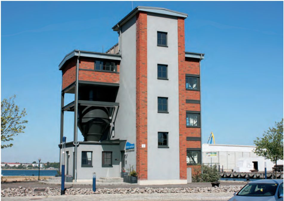
Abb. 4 Wismar: Metamorphose eines Getreidestaub-Verladesilos zum Feriendomizil »Chalet Nautique«.
