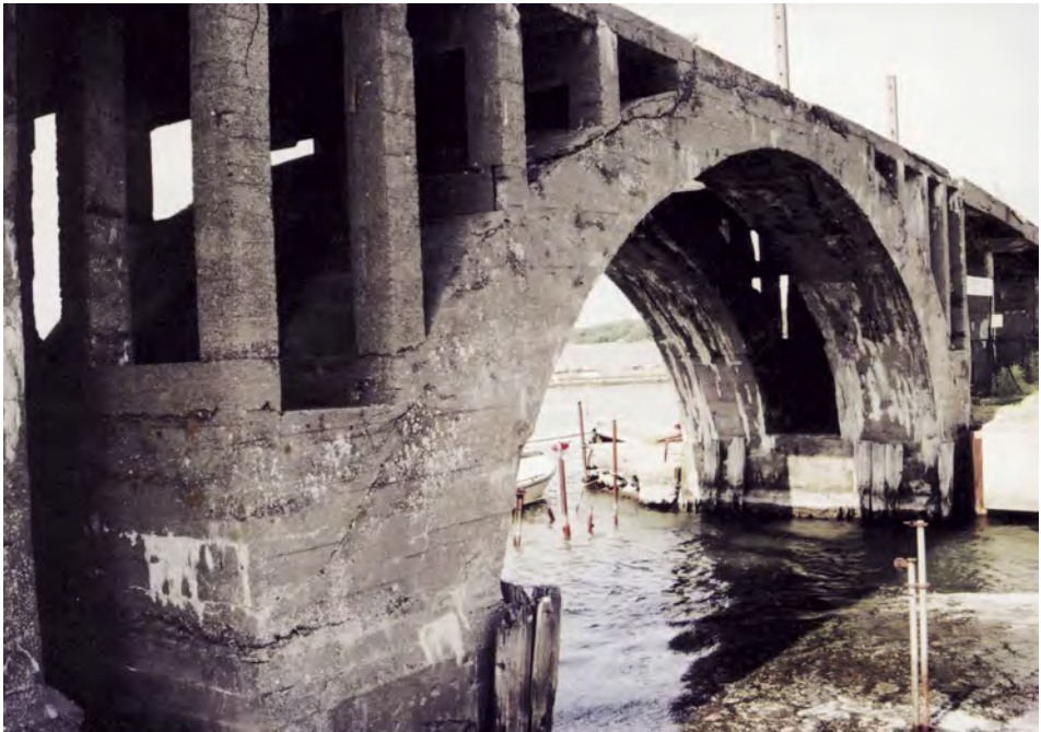
Abb. 3 1914 erbaute Verladebrücke für den geplanten Kreidehafen in Wiek auf Rügen. (Foto: Gerhard Parchow)
