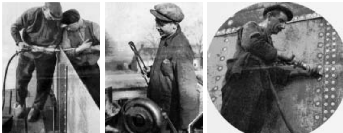
Abb. 5-7 Moderner Schiffbau bei Gebr. van Diepen im Jahr 1933 (von links): Nieter und Gegenhalter, Nietenjunge mit Feldschmiede, pneumatisches Stemmen.
