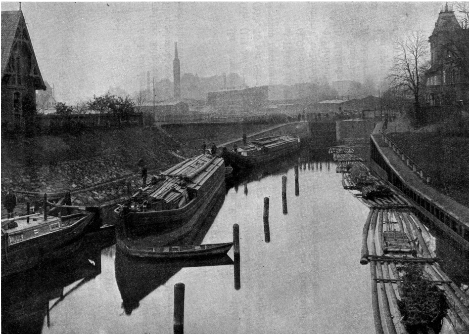
Abb. 6 Finowmaßkähne und ein Floß warten auf dem Kanal auf die Schleusung. Für das Floß machen die Schleusenabmessungen des Kanals ein Auseinanderkoppeln in zwei Teile für den Schleusungsvorgang erforderlich. (Aus: Karl Ebner: Flößerei und Schifffahrt auf Binnengewässern. Wien, Leipzig 1912, S. 230)
