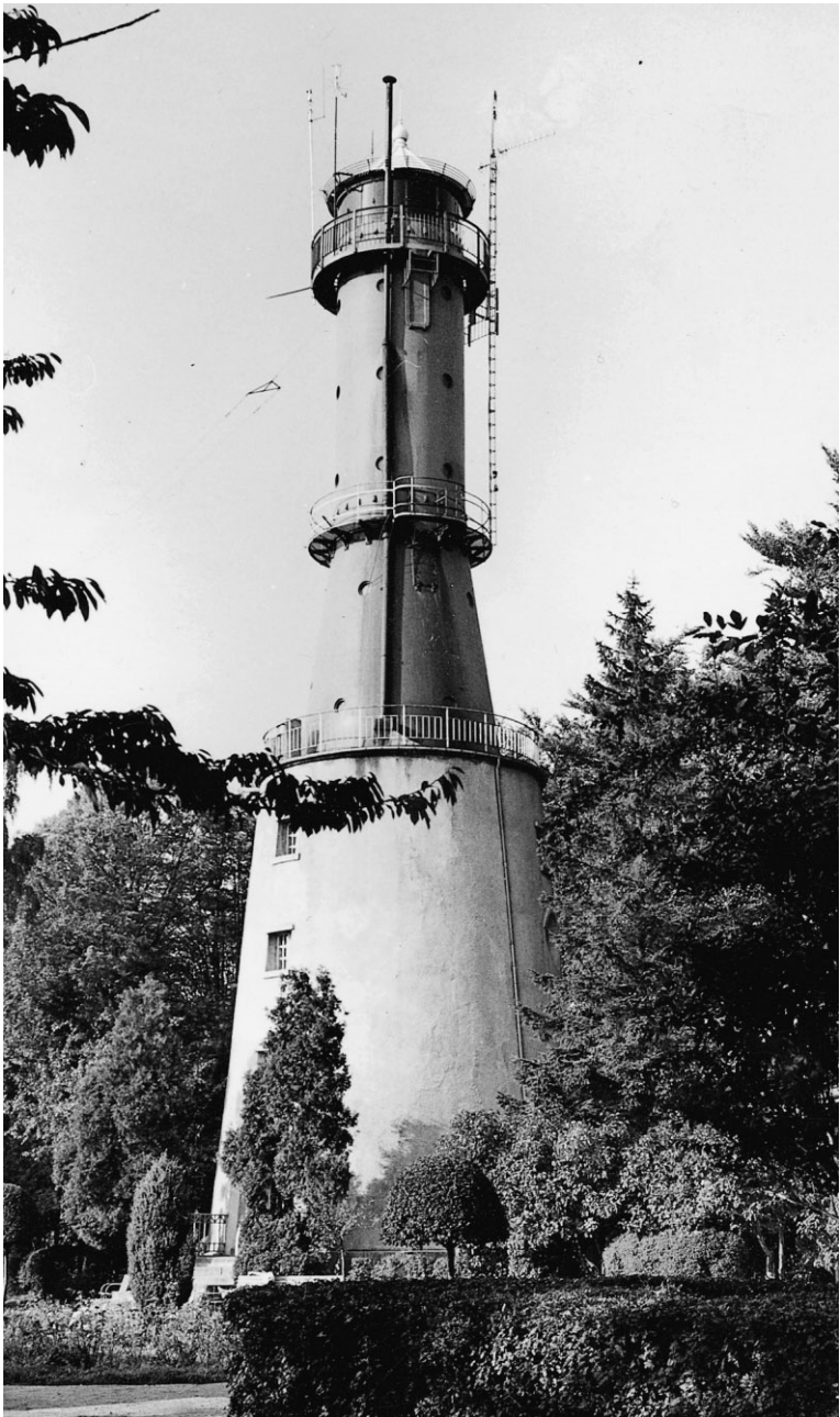
Abb. 16 Der erste Leuchtturm in Rixhöft nach der dritten Modernisierung 1978, während der er um einen 8 m langen Stahlzylinder erhöht wurde; heutiger Zustand. (Foto: Slg. des Verf.)
