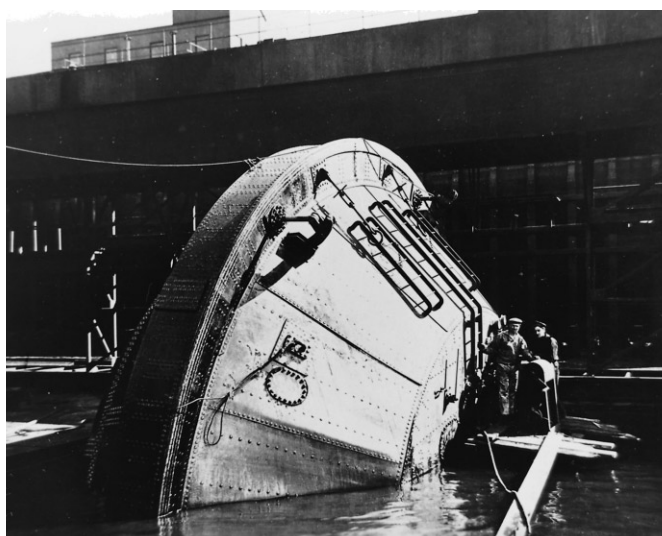
Abb. 9–11 Unterseebootprüf- dock für die Kaiserliche Marine, gebaut 1917 von der Brücken- bau Flender A.-G. Die Bilder zeigen das Dock mit dem genieteten Endboden, der geöffneten Einfahrseite sowie dem Verschlusskörper.
