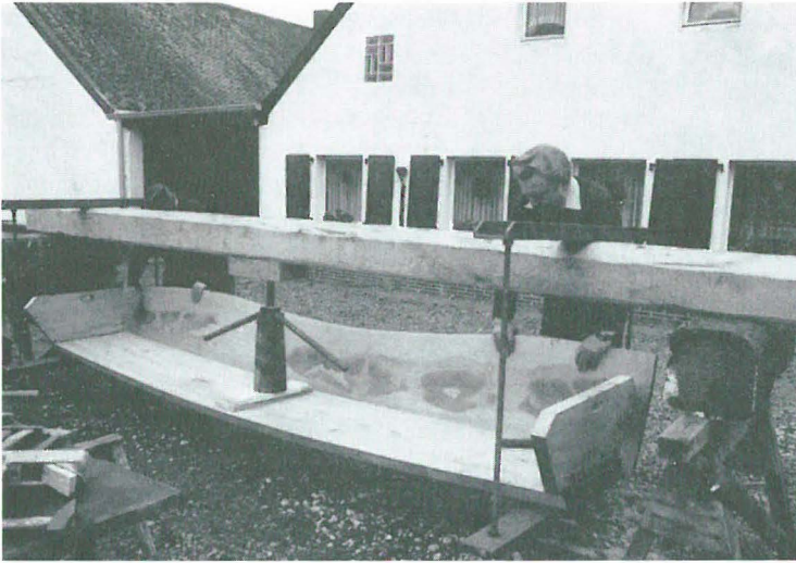
Abb. 12 Bootsbau- platz Vosdellen in Nettetal-Sassen- feld mit der Kon- struktion zur Auf- biegung des Boots- bodens. (Foto aus: Werner Böcking, Nachen und Netze. Köln 1982, S. 95)
