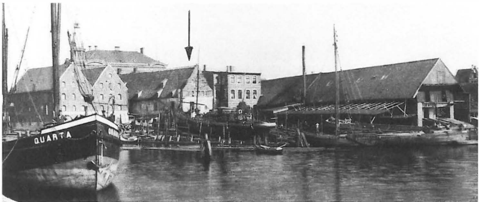
Abb. 5 Die Stelle der Emdener Schiffsablauf-Tragödie von 1651, fotografiert um die letzte Jahrhundertwende – vor 1903 –, als es dort noch Werftbetrieb (Cassens) mit Helling und Stapelläufen gab. Im Vordergrund das Wasser des Falderndelfts; der senkrechte Pfeil oben weist auf die Rückseite des früheren, damals noch bestehenden Fleischhauses. (Fotoarchiv Fokuhl, Emden).
