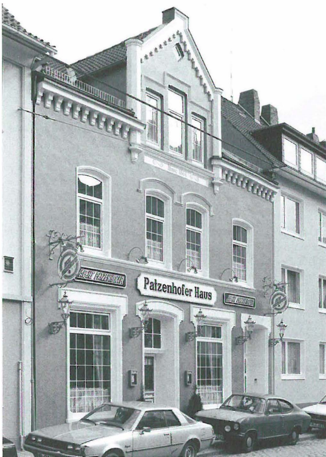
Haus des ehemaligen Heuerbaases Th. Blank, seit Januar 1984 als Gaststätte genutzt. (Foto: Laska/DSM)
