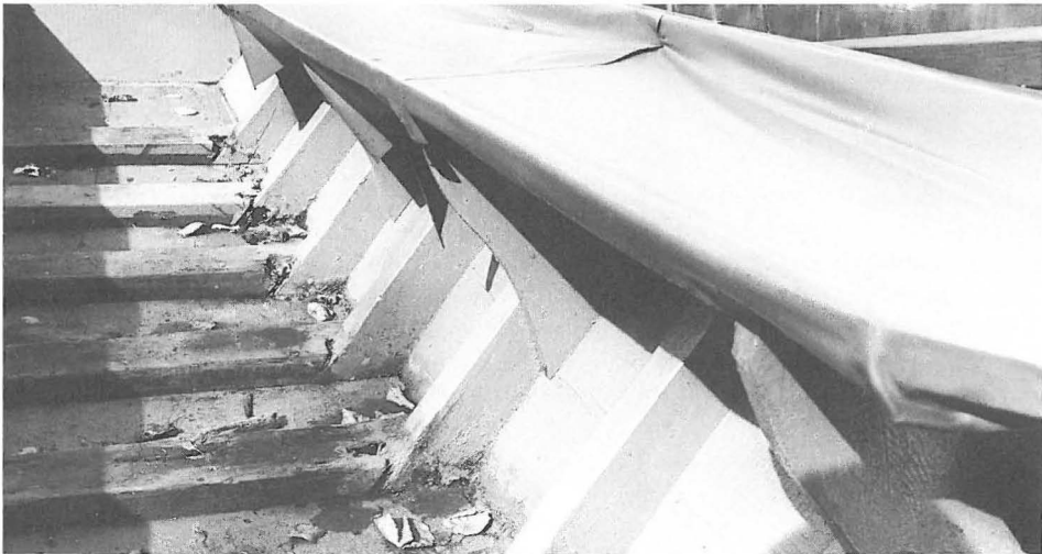
Abb. 7 Teil der auf Konsolen aufliegenden Bank für die Passagiere
