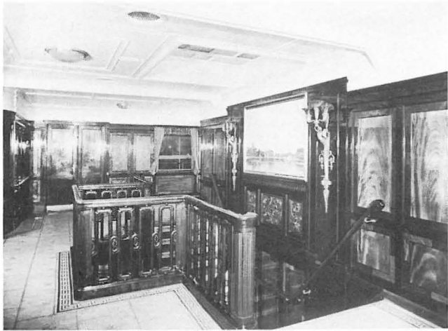
Treppenniedergang vom Vorraum auf das Promena- deck.
