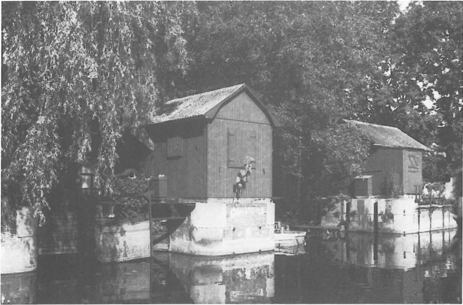
Schleuse des Schleswig-Holsteinischen Kanals (Eiderkanal) bei Kluvensiek (Kreis Rendsburg-Eckernförde, 1987)
