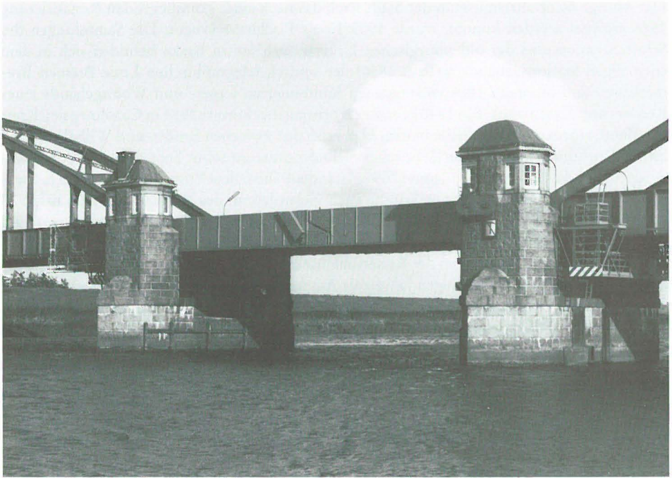
Straßenbrücke über die Eider bei Friedrichstadt (Kreis Nordfriesland, 1987)
