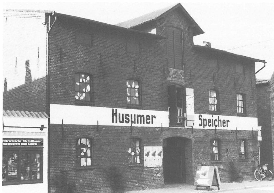
Speicher am Binnenhafen in Husum (Kreis Nordfriesland, 1987)
