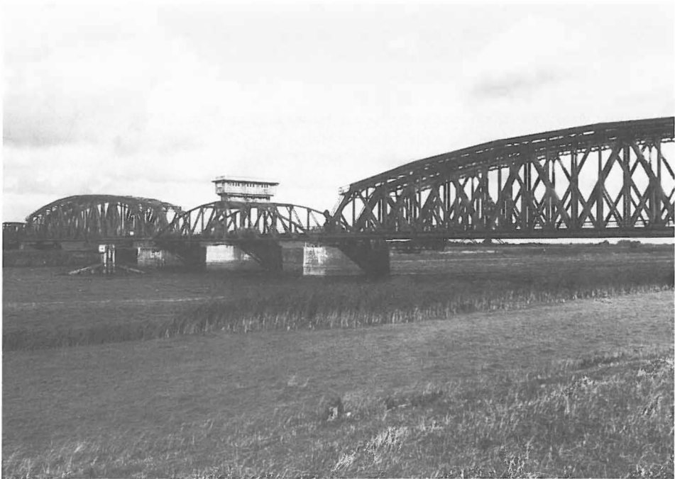
Eisenbahnbrücke über die Eider bei Friedrichstadt (Kreis Nordfriesland, 1987)
