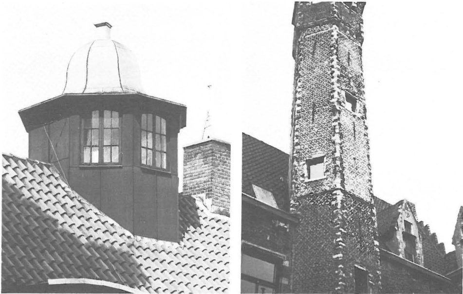
Links: Die einzige bewahrte »echte« Kiekenburg in Helsingør reitet auf dem Dach des Hauses der ehemaligen englischen Klarierfirma Belfour & Ellah, Stengade 61. Das Gebäude wurde 1789 errichtet. Der achteckige Aufbau ist rotbraun angestrichen, und das metallgraue Dach hat eine geschweifte Barockform. Von hier oben hatte man eine prächtige Aussicht über den Hafen und die Reede der Stadt und über den zwischen Helsingør und Helsingborg nur 4 km breiten Sund. (Foto: H. Hauch) – Rechts: In der alten flämischen Handelsstadt Antwerpen findet man hohe, gemauerte Türme, von denen aus man die Schifffahrt auf der Schelde beobachten konnte. Renaissance-Haus in Heilig Geest Straat. (Foto des Verfassers)
