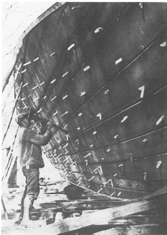
Abb. 15 Die Holznägel werden verkeilt.
