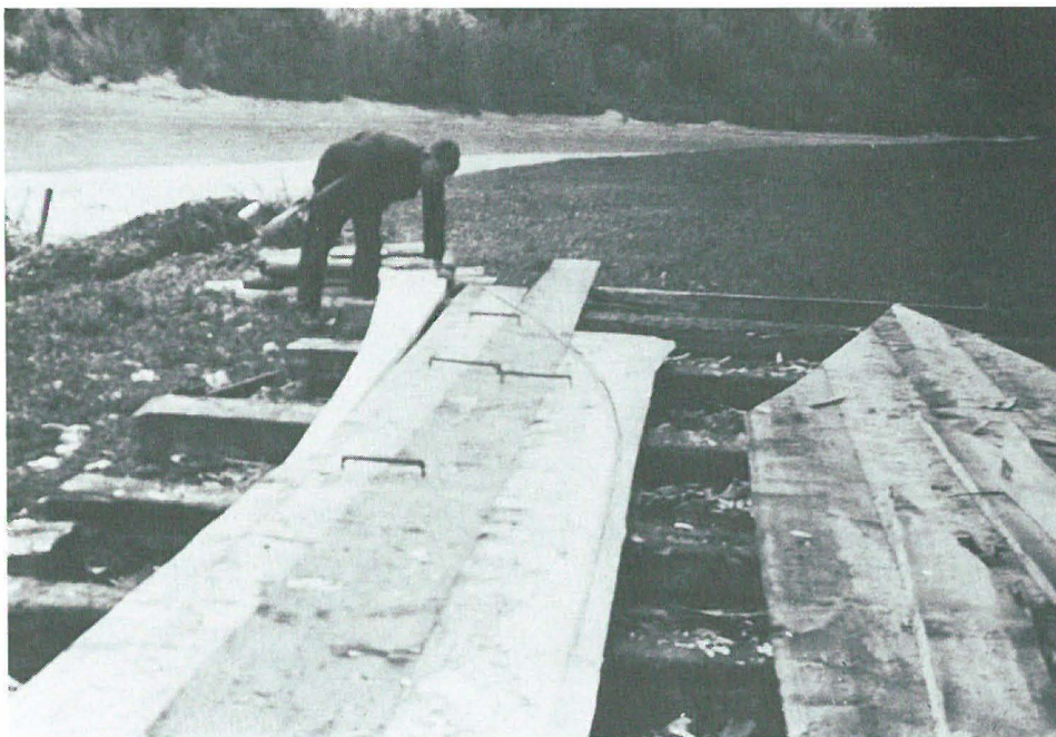
Abb. 4 Die oberste Seitenplanke am Bug (süddeutsch: Gransenblatt) wird angepaßt.
