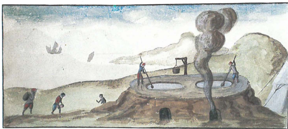
Abb. 17 Tranöfen mit zwei Speckpfannen. Auf dem begehbaren Rand zwei Männer mit langstieligen Schöpflöffeln. Die äußere Ofenwandung ist aus Natursteinen und Geröll gebaut. (Fol. 18v; 7,5 x 17,5 cm).
