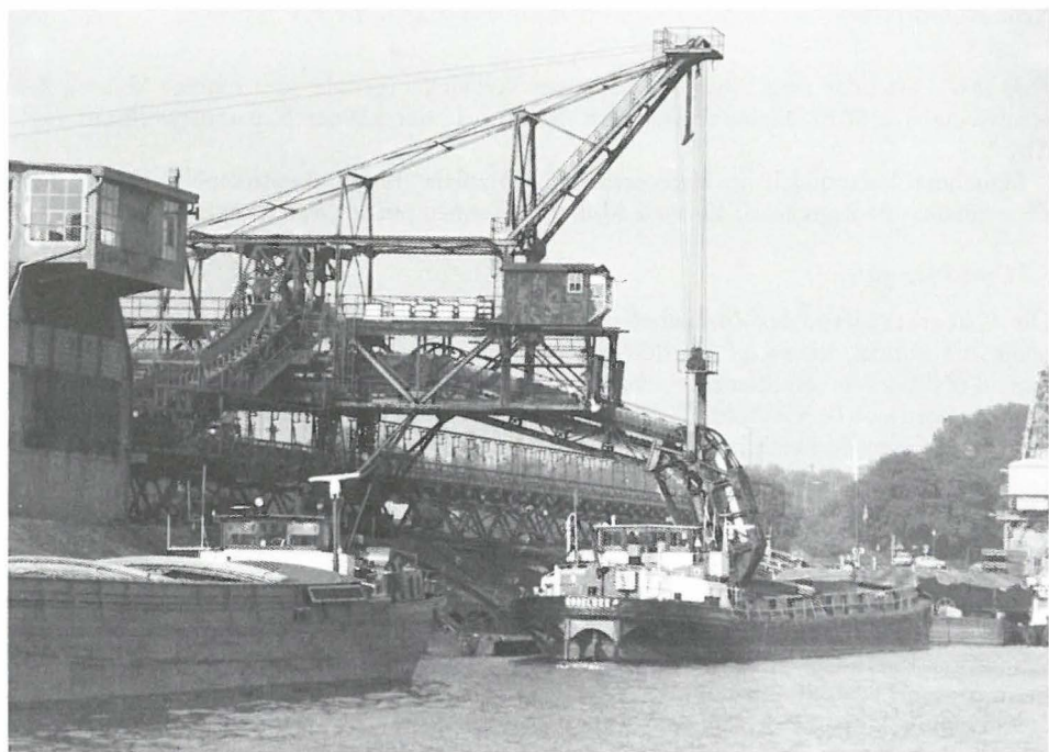
Alte Kohlenmischanlage im Ruhrorter Hafenbecken B (um 1980). Quer zum Bild das Zufuhrförderband. Der Laderüssel war in der Höhe und zur Breite hin verfahrbar. Die Anlage konnte am Kai entlangfahren und die Kähne beladen.
