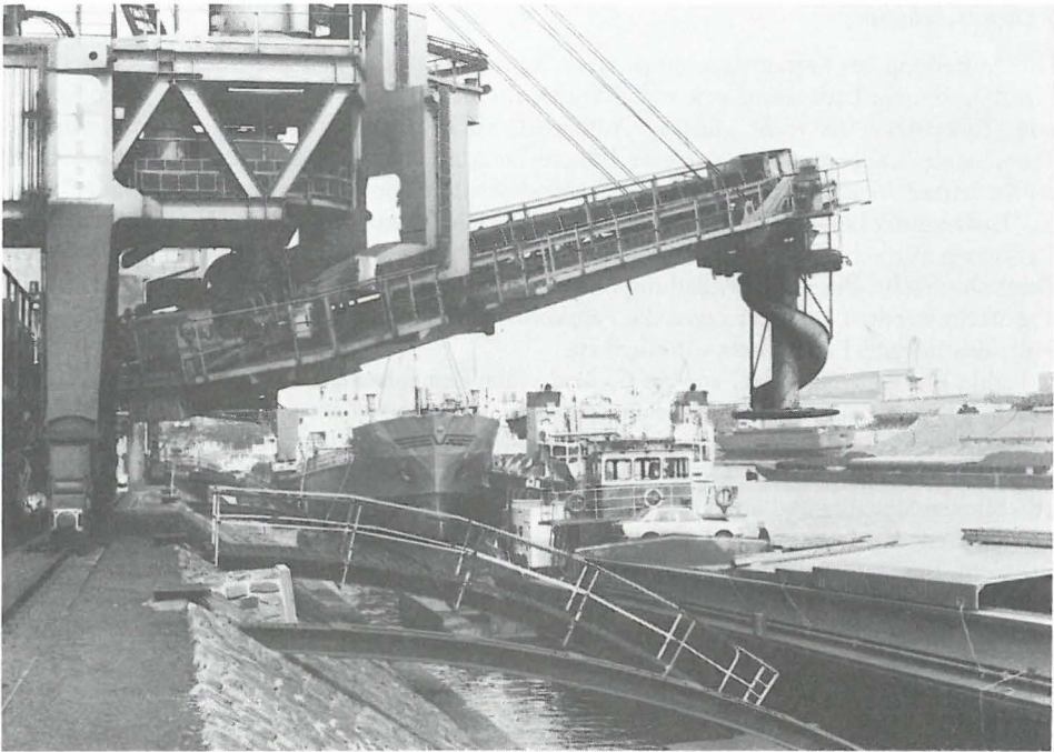
Kohlenmischanlage im Ruhrorter Hafenbecken B (1985). Durch die Schneckenrutsche wird ein kohlenchonender Verladevorgang ermöglicht.
