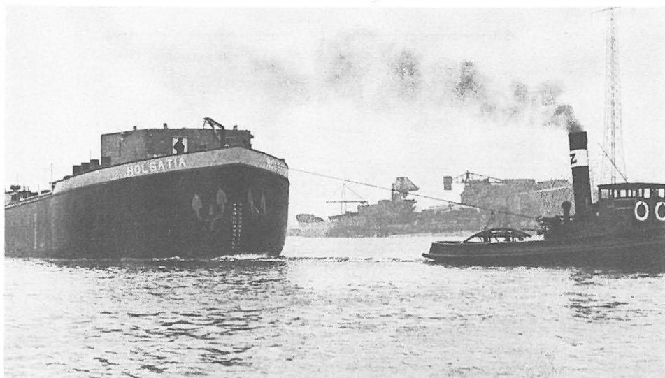
Tankschleppkahn HOLSATIA der Reederei Van Ommereen, Rotterdam, gebaut auf der Schiffswerft Hitzler, Lauenburg, Elbe. Die HOLSATIA wies beachtliche Maße auf: 100 m lang, 12 m breit, 2,8 m Tiefgang. Baujahr 1955. Wie in der Nachkriegszeit »modern«, war der Bug recht völlig gestaltet worden – allerdings noch mit geradem Steven! (Archiv Hitzler)
