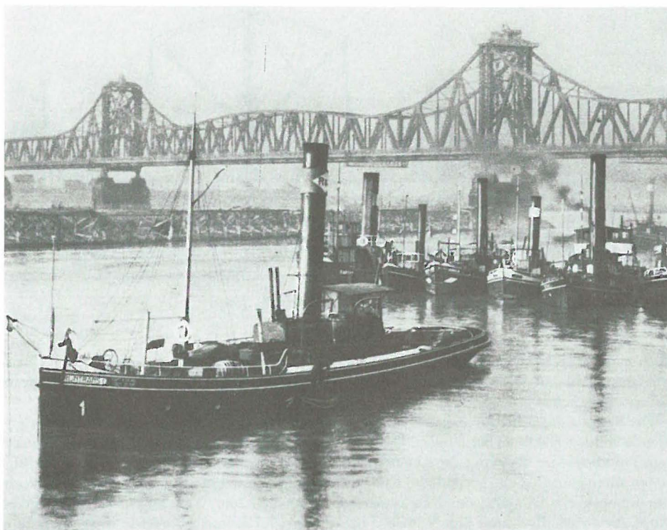
Bugierschlepper in Ruhrort. Die meisten kleineren Schraubenboote waren »rank und schlank« gebaut – mußten sie doch mit ihren 100–200 PS noch einen Kahn von 1300 t schleppen können. Ältere Boote hatten nach 1900 noch einen Klipperbug, noch ältere einen Kreuzerbug. Einige Boote auf dem Rhein stammten von Elbe und Oder. Meist besaßen sie einen wesentlich plumperen »Kopf« als die Boote vom Niederrhein. (Archiv Duisburg-Ruhrort Häfen AG)
