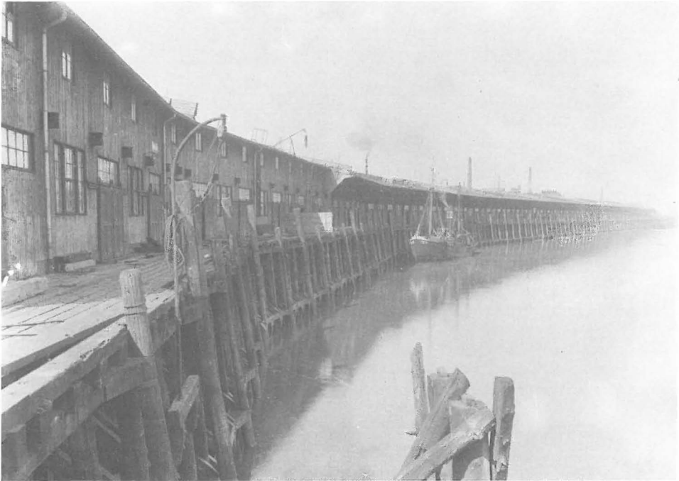
Auktions- und Packhalle I an der Westseite des Fischereihafens I mit der hölzernen Bohlwerkkonstruktion, die später durch eine massive Kaje ersetzt wurde. (1913, Hansestadt Bremisches Amt Bremerhaven)
