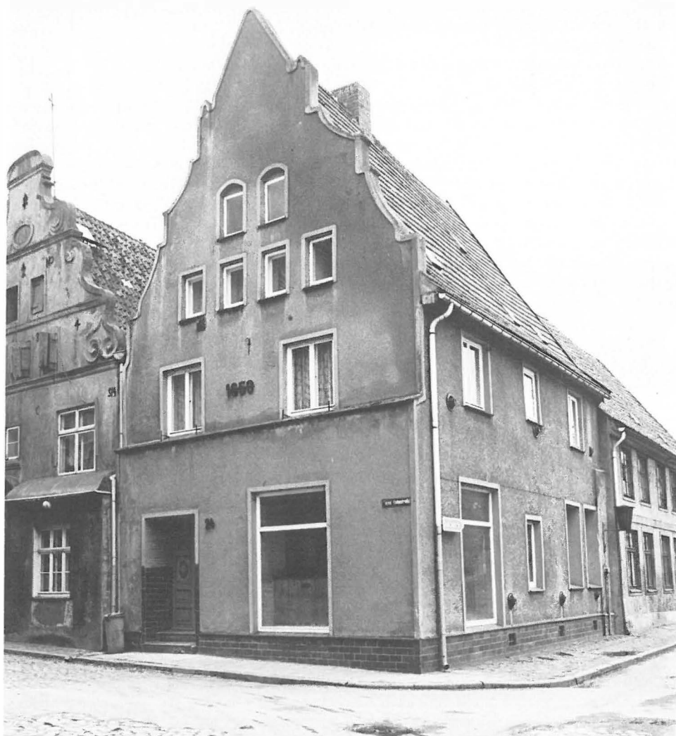
Das 1555 gebaute Haus Kleine Hohestraße Nr. 24, Ecke Runde Grube, des Schuhmachermeisters August Fust, das auch als Kirche für schwedische Seeleute bis 1945 diente. Links daneben das Haus des Bäckermeisters Volkert Lammert und rechts das Geschäftshaus Joh. Fr. Dinnies, Inhaber Kaufmann Paul Steinhagen. (Foto aus dem Jahre 1979)
