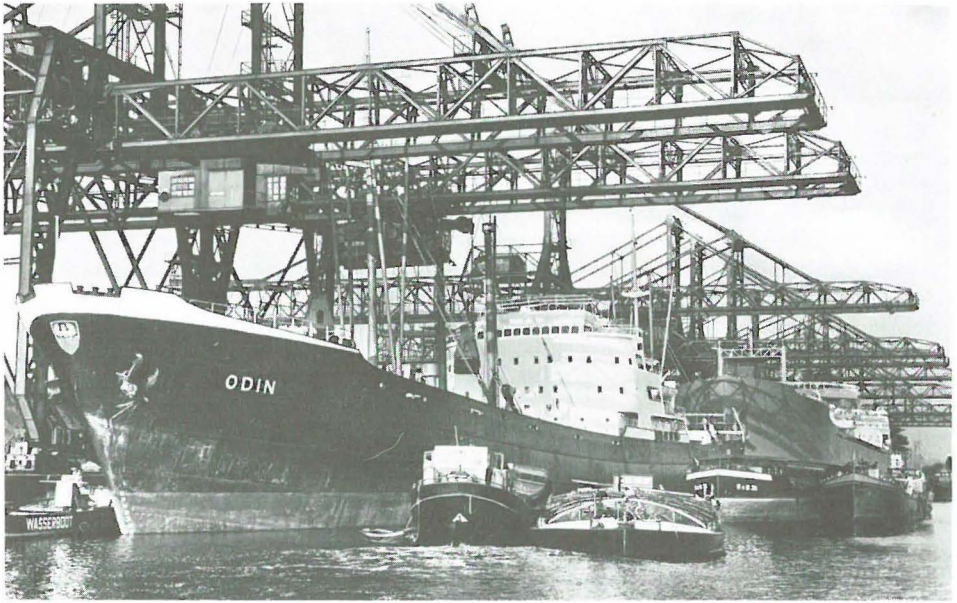
Abb. 14 Massengutumschlag im Hafen Emden am Erz kai. (Foto: Schöningh & Co, Lübeck) In den fünfziger Jahren herrschte am Erz- und Kohlenkai noch reges Leben. 5 000–15 000-t-Seedampfer brachten Erz oder luden Ruhrkohle bzw. Koks. Die Schleppkähne (mit max. 750 t beladen) gingen längsseits Seeschiff und wurden von Kranbrücken bedient. Im Bild ein Weserkahn und ein DEK-Kahn (S & B 31, ein Schiff der Emdener Firma Schulte & Bruns, eine Firma, die zusammen mit den Reedereien WTAG und Lehnkering maßgeblich am Transport von Massengütern beteiligt war).
