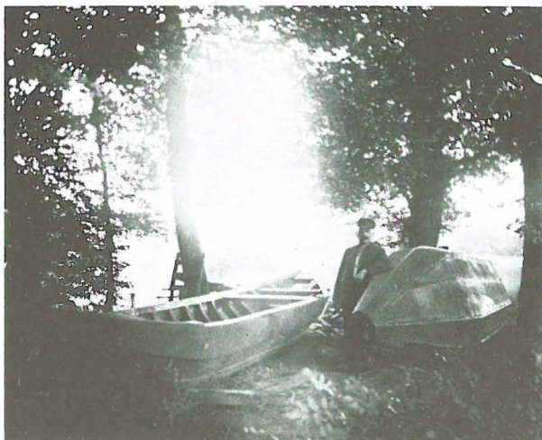
Der Bootsbauplatz des Bootsbauers Friedrich Wilhelm Schönenberg um 1900 mit zwei im Bau befindlichen Nachen.
