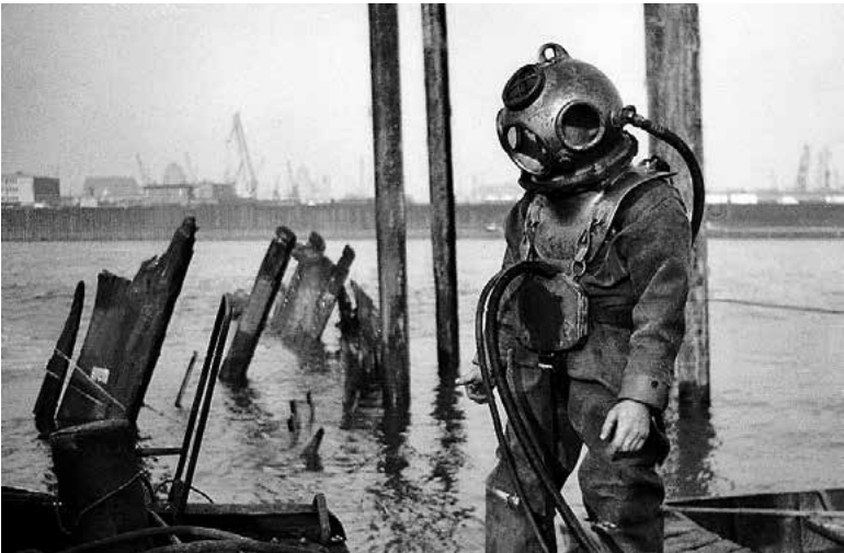
Die Bergungsarbeiten im Bremer Hafen waren kompliziert und aufwendig. Ein Saugbagger und ein Taucherglockenschiff kamen zum Einsatz.
